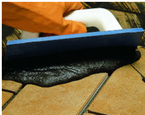
Chituirea unei podele exterioare de gresie klinker cu Keracolor GG amestecat cu Fugolastic
