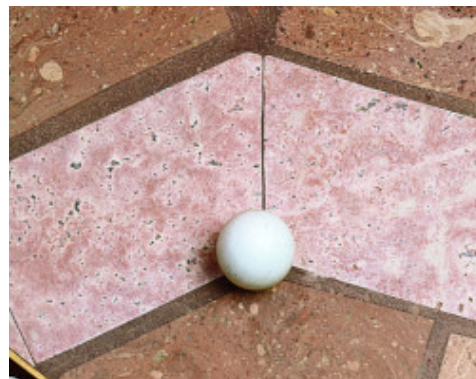
Pardoseala din teracota slefuita in situ, chituita cu Keracolor GG amestecat cu Fugolastic
