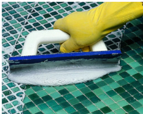
Chituire mozaic de sticla cu Keracolor FF amestecat cu Fugolastic
